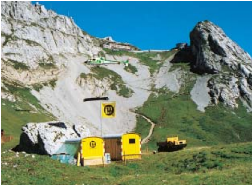
Baustelle auf dem Pilatus
