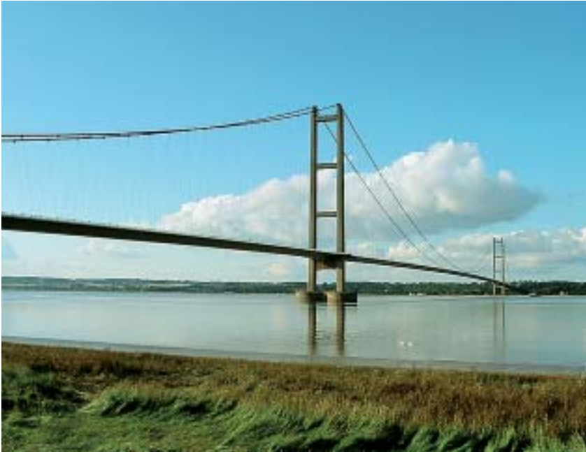
Die Humber-Brücke mit einer Mittelspannweite von 1410 m ist die viertgrösste Hängebrücke der Welt
