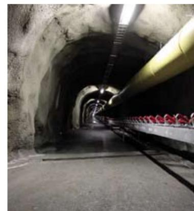
Durch das Gefälle von 7% und das Eigengewicht des Materials arbeitet die Förderanlage praktisch stromlos.
