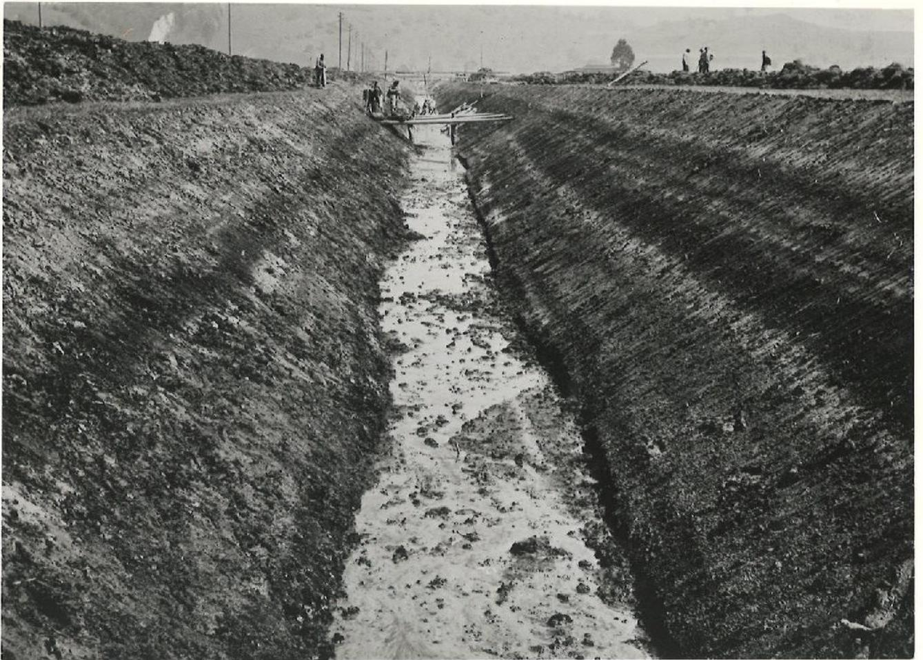
Bau des Vorflutkanales. Als Vorflutkanal dient der alte Mehlbach. Er musste zu diesem Zwecke 2 bis  $2\frac{1}{2}$  m tiefer gelegt werden.
