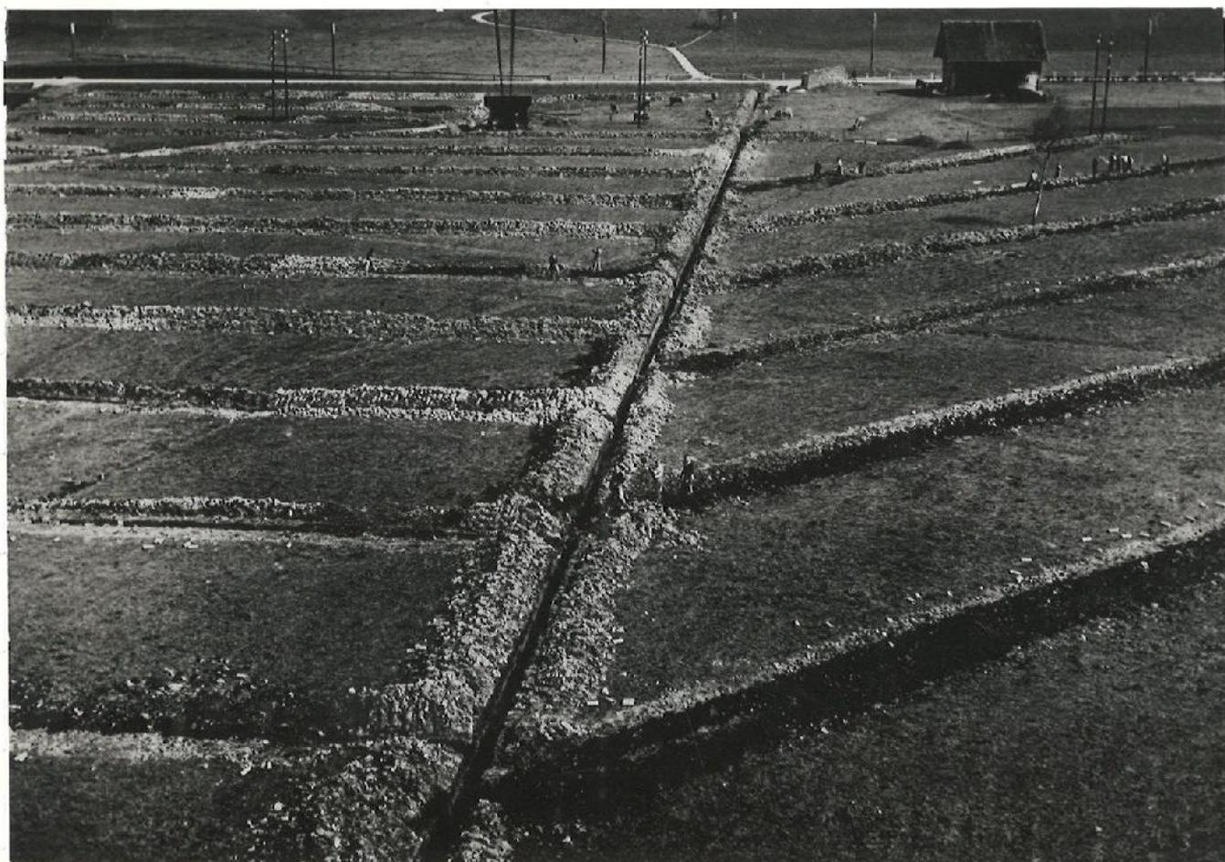
Teilansicht der Drainage, eine Sammelleitung mit Saugleitungen im Bau.
