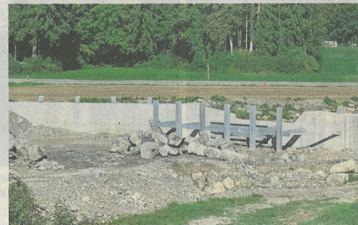
Links oben: Am ersten Posten des Rundgangs erhielt man einen Überblick über das Projekt. Links unten: Der Geschiebesammler schützt das Dorf im Notfall vor Geröll und anderem Material. Rechts: Der Bruderhausbach hat nun auch bei starken Unwettern genug Platz.
