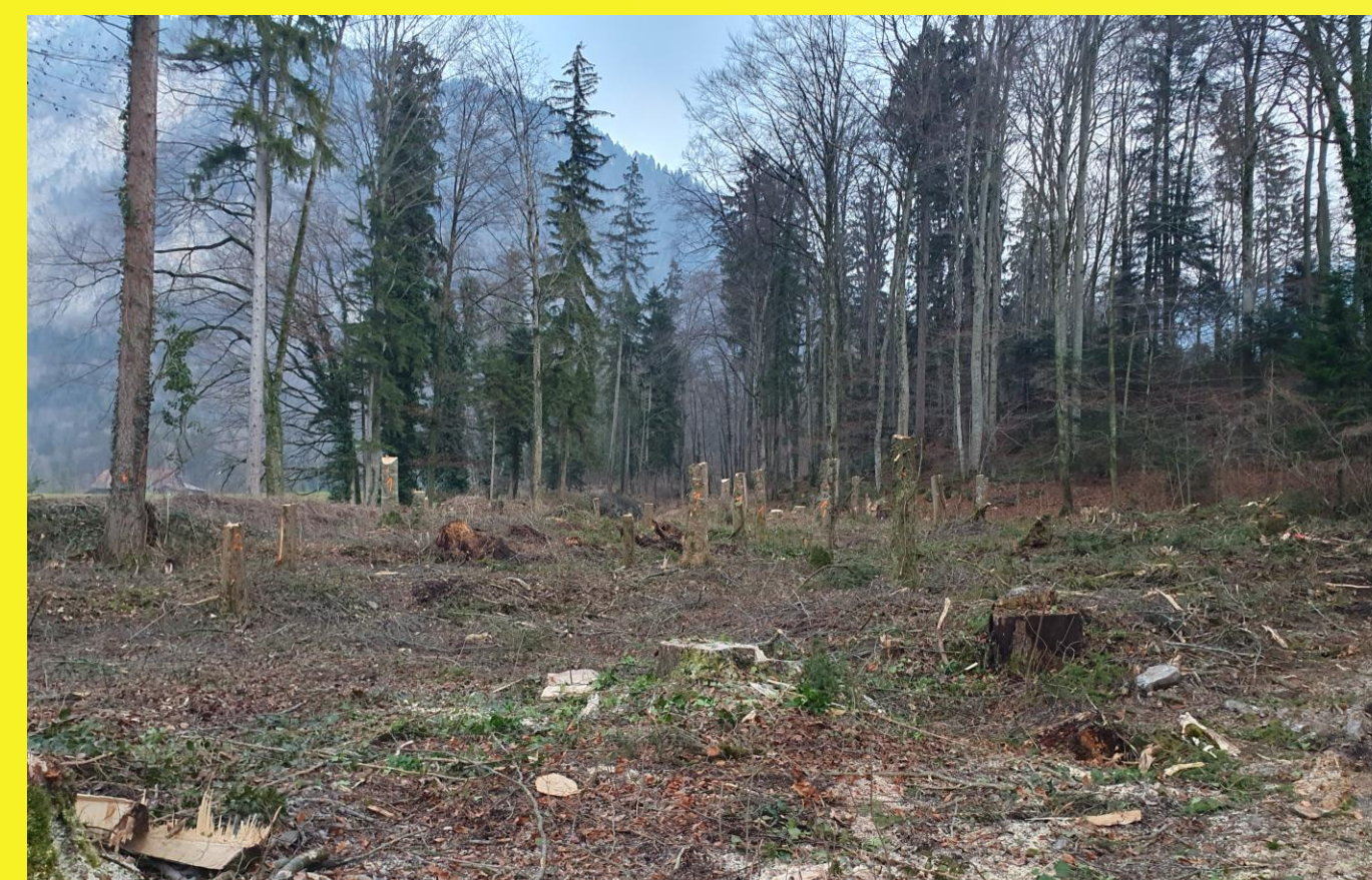
Bereitstellung von hohen Wurzelstöcken bei Rodung für Revitalisierung (Foto: H. Britschgi, Feb. 2025)
