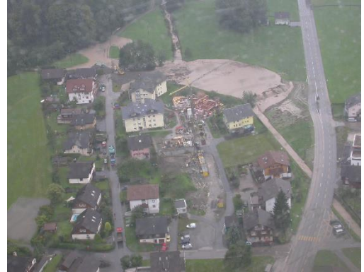
Hochwasser 2005, Geschiebesammler St. Jakob mit angrenzendem Siedlungsgebiet
